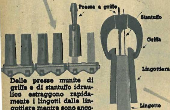
Delle presse munite di griffe e di stantuffo idraulico estraggono rapidamente i lingotti dalle lingottiere mentre sono ancora ad alta temperatura.
